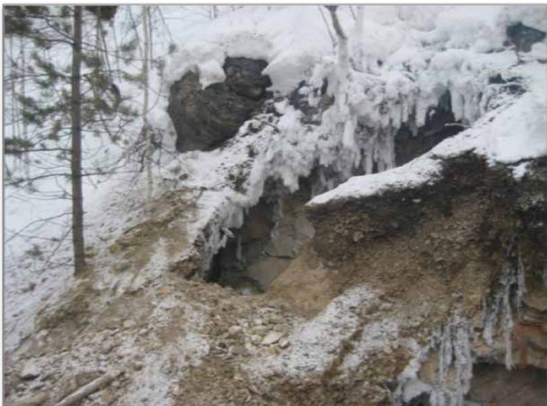
*Фото 13. Пятно протаивания после проведения вскрышных работ.*
