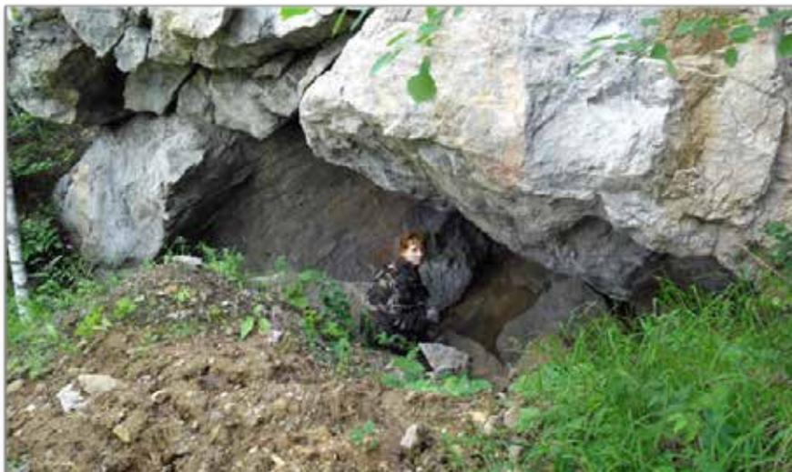
*Фото 21. Стенка отрыва и провал свода в теле карьера протрассового резерва. В морозный период внутренние и нависающая часть внешней стены полностью покрыты снежно-ледовым конденсатом (фото В. Михеева).*
